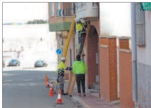
FOTO: Selena García / Trabajadores instalan el servicio en el barrio
