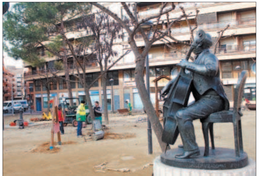
FOTO: Tony Alcántara / Los operarios trabajan en la remodelación de la plaza Pau Casals de Lleida
